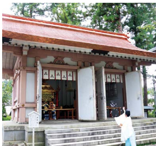
修繕工事を終えた神輿庫
