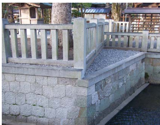
修繕後の玉垣
