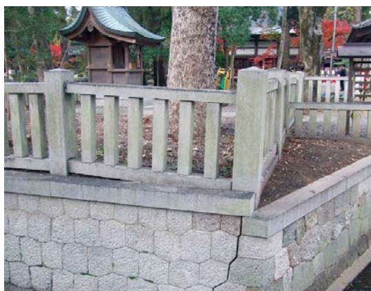
修繕前の玉垣
