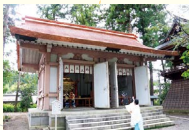
神輿庫屋根葺替工事
